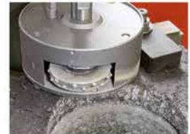
Werkzeug zur Straßensanierung
